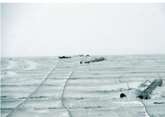
Каскадное разрушение опор 10 кВ
