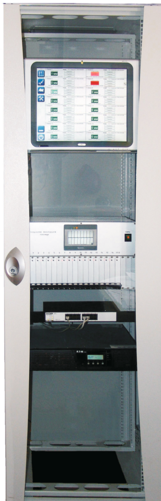
Стойечный вариант промышленного образца системы мониторинга гололеда на 16 каналов [2012 год]
