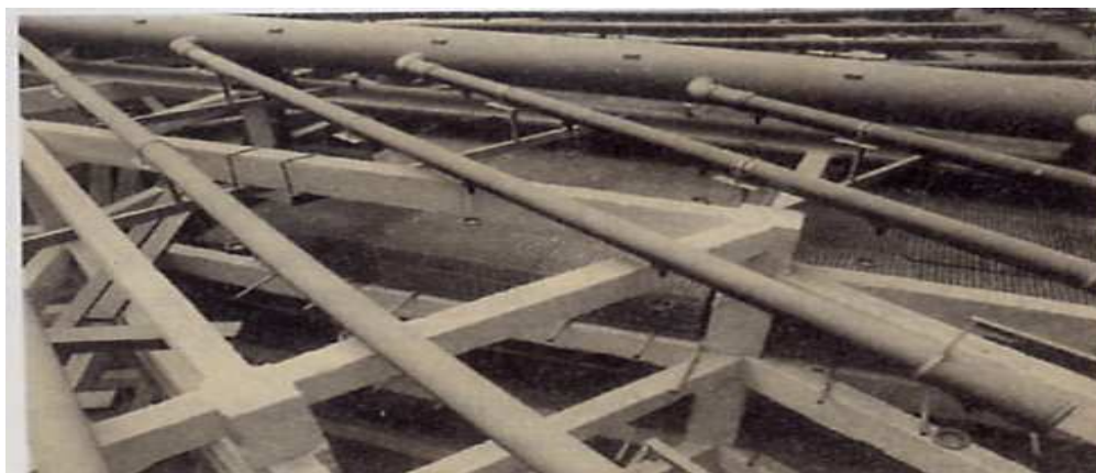
Рис. 1.10. Система водораспределения в градирне с распылением вниз
