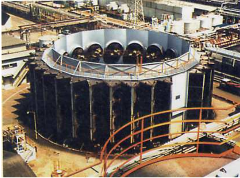
Рис. 6.3. Система ГЕЛЛЕР с принудительной тягой с устройством водяного орошения [3] .
