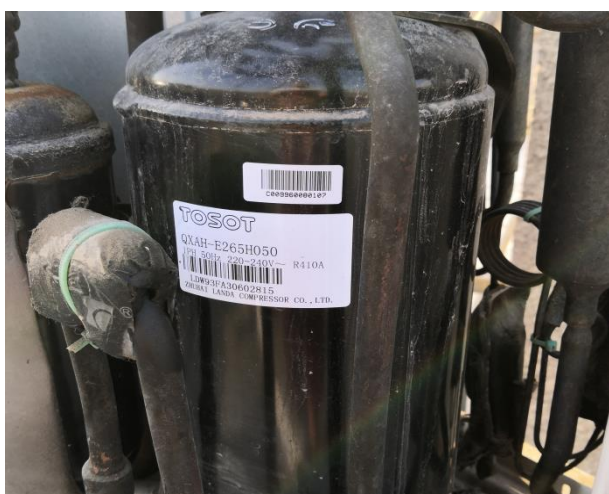
Рис. 3.2. Роторный компрессор
