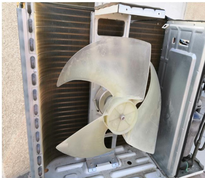
Рис. 3.3. Конденсатор наружного блока
