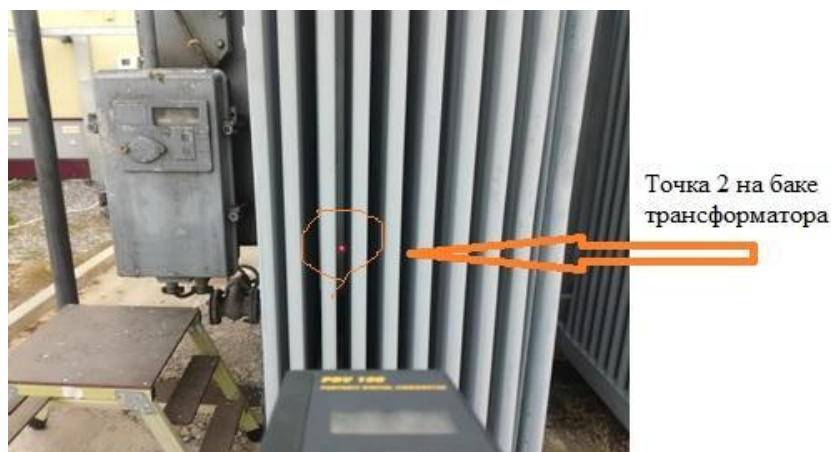
Рисунок 13 – Момент измерений вибрации трансформатора ТМН в режиме XX
