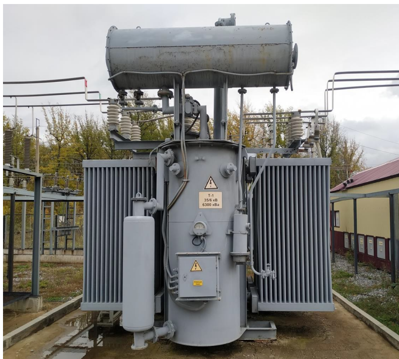
Рисунок 4.2 – Трансформатор ТМН – 6300/35
