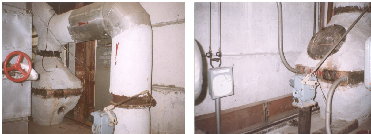
Рисунок 1 – Конденсационный теплоутилизатор за котлом ДЕ-10-14 ГМ Ульяновской ТЭЦ-3
