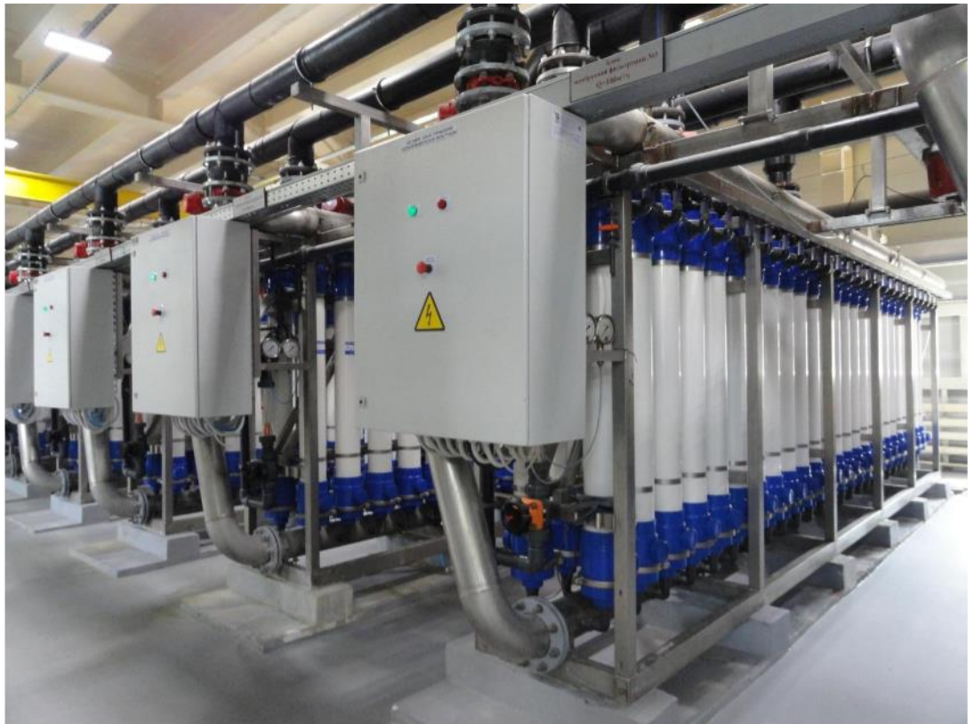
Рис. 4.12 Блоки мембранной фильтрации ВПУ Казанской ТЭЦ-2
