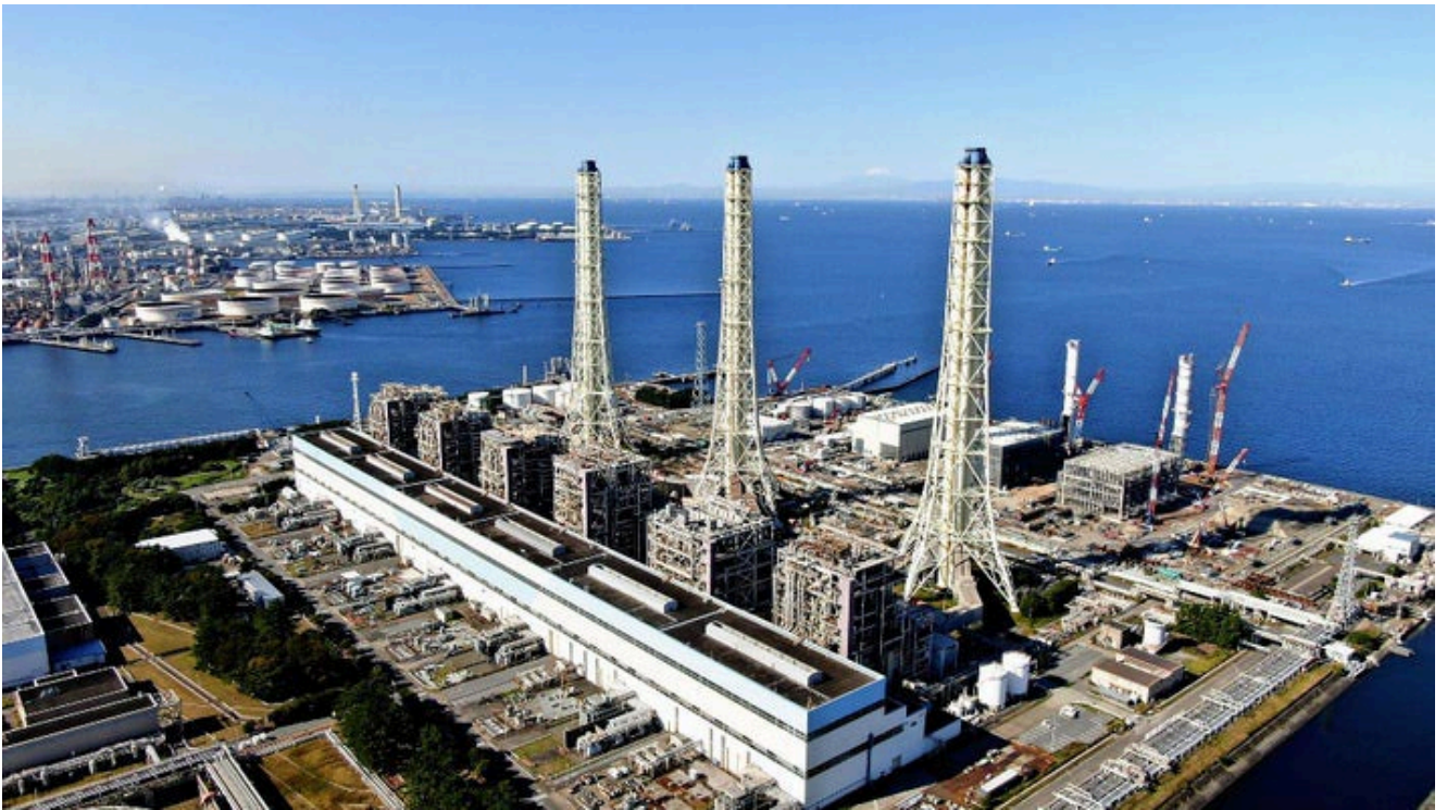
Рисунок 1.3.3 — Многоствольные дымовые трубы в каркасной башне на ТЭС JERA в префектуре Тиба, Япония
