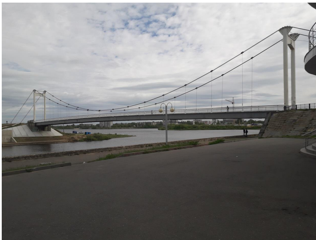
Рис. 1.8 Мостовой переход теплопроводов через р.М.Кокшага в г.Йошкар-Ола
