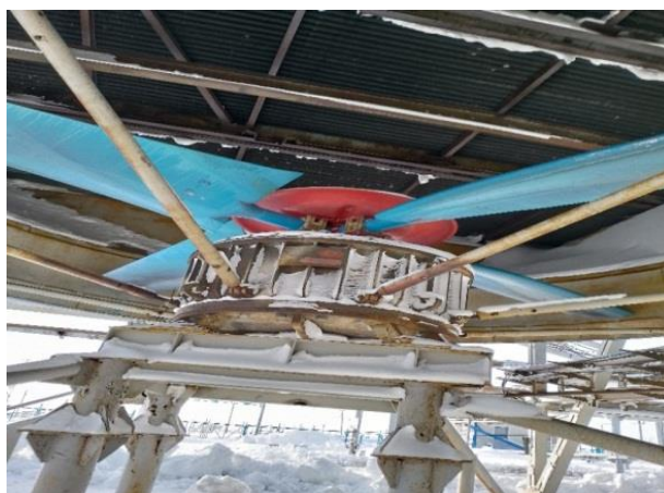
Рисунок 2.2 – Внешний вид АД серии ВАСО16-14-24 со стеклопластиковым рабочим колесом
