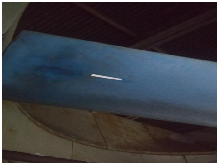
Рисунок 2.19 – Светоотражающая полоска на лопасти АВО газа
