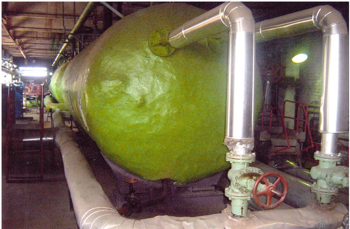
Рис. 6.8. Общий вид вакуумно-кавитационного деаэрата ЦОК СамГРЭС
