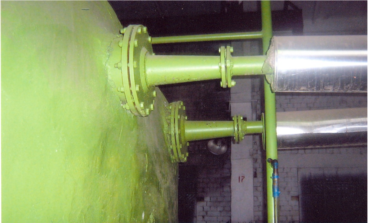
Рис. 6.7. Вид на кавитационно-разгонные устройства (сопла переменного поперечного сечения) вакуумно-кавитационного деаэрата
