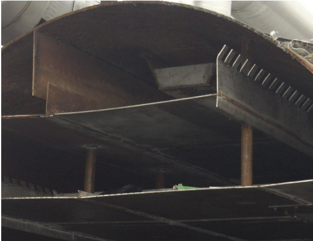
Рис. 6.5. Первая и вторая струйные тарелки ДВ-800 ст. № 5
